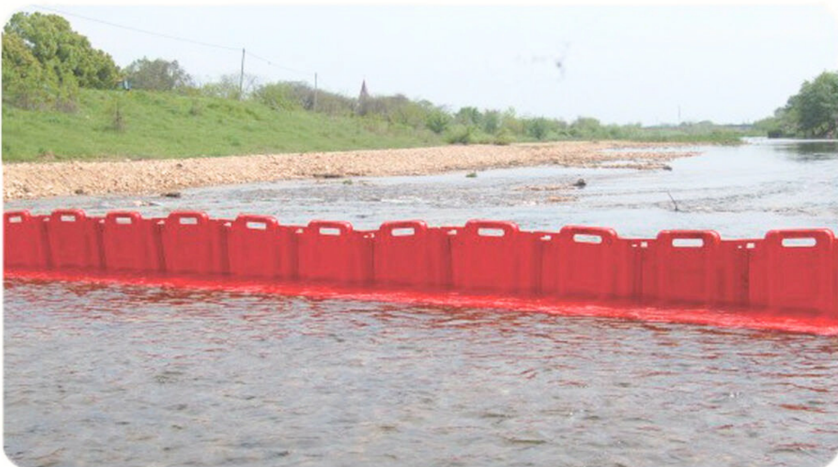
ติดตั้ง Flood Barrier 14 ชิ้น ใช้เวลา เพียง 5 นาที ช่วยประหยัดเวลาเมื่อเทียบกับการ ติดตั้งด้วยกระสอบทราย
